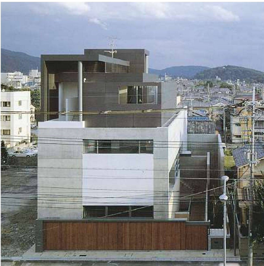
TAK-Building, Kyoto, Ansicht von Süden. – Bild: © Hisao Suzuki
