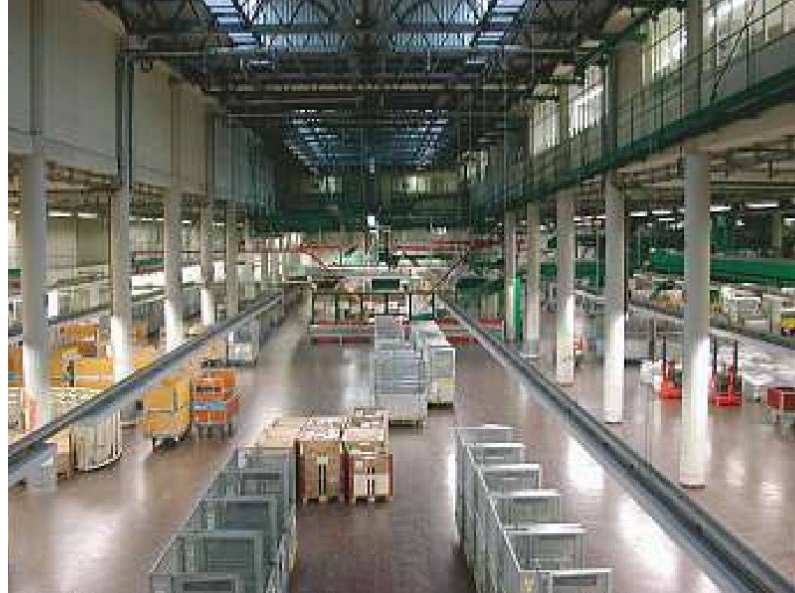
Postbetriebsgebäude vor dem Umbau. – Bild: Kanton Luzern, Amt für Hochbauten und Immobilien
