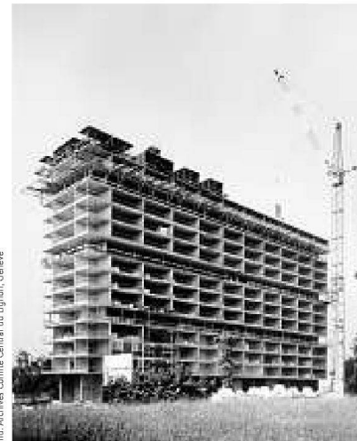
Rohbau mit stählerner Tunnelschalung, 1966
