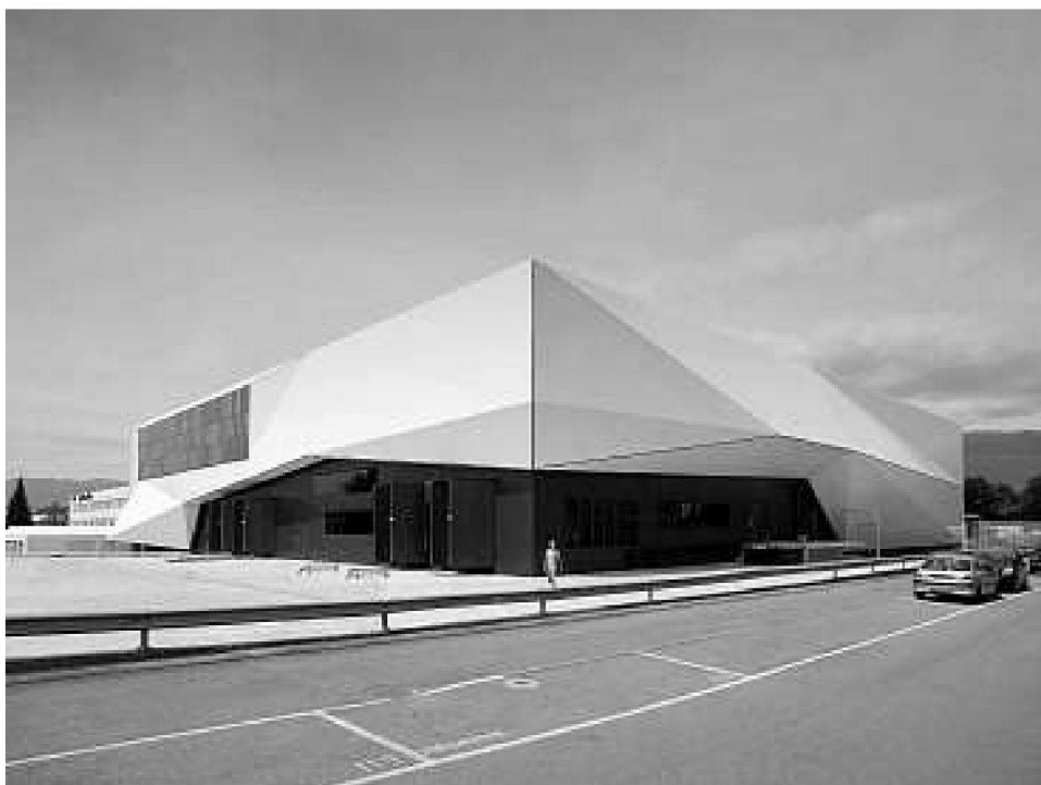
Vue depuis la rue: accès aux plateformes de chargement
