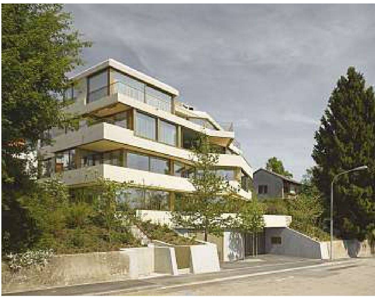
Vorzone und Eingang, als öffentlicher Raum aufgewertet
