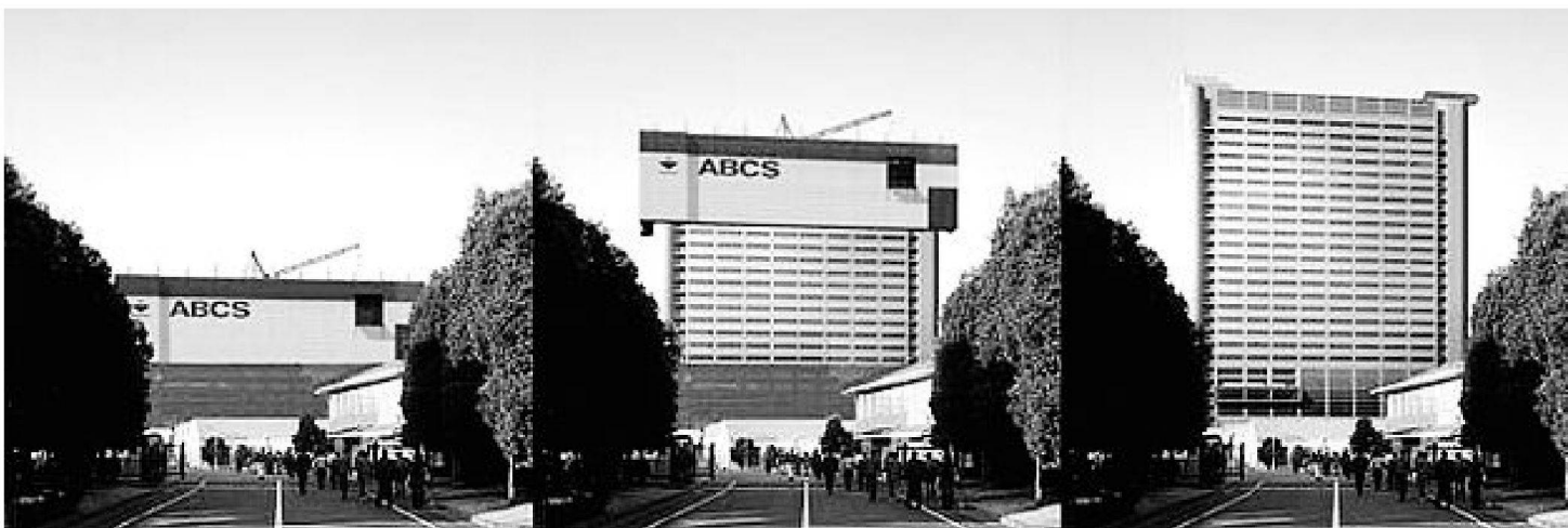
Automatisierte Baustelle in Japan, Bauverlauf der ABCS (Automated Building Construction Systems). – Bild aus: M. Eidenbenz, P. Filipaj und S. Menz (Hrsg.), Changes , VDF Hochschulverlag, Zürich 2010.
