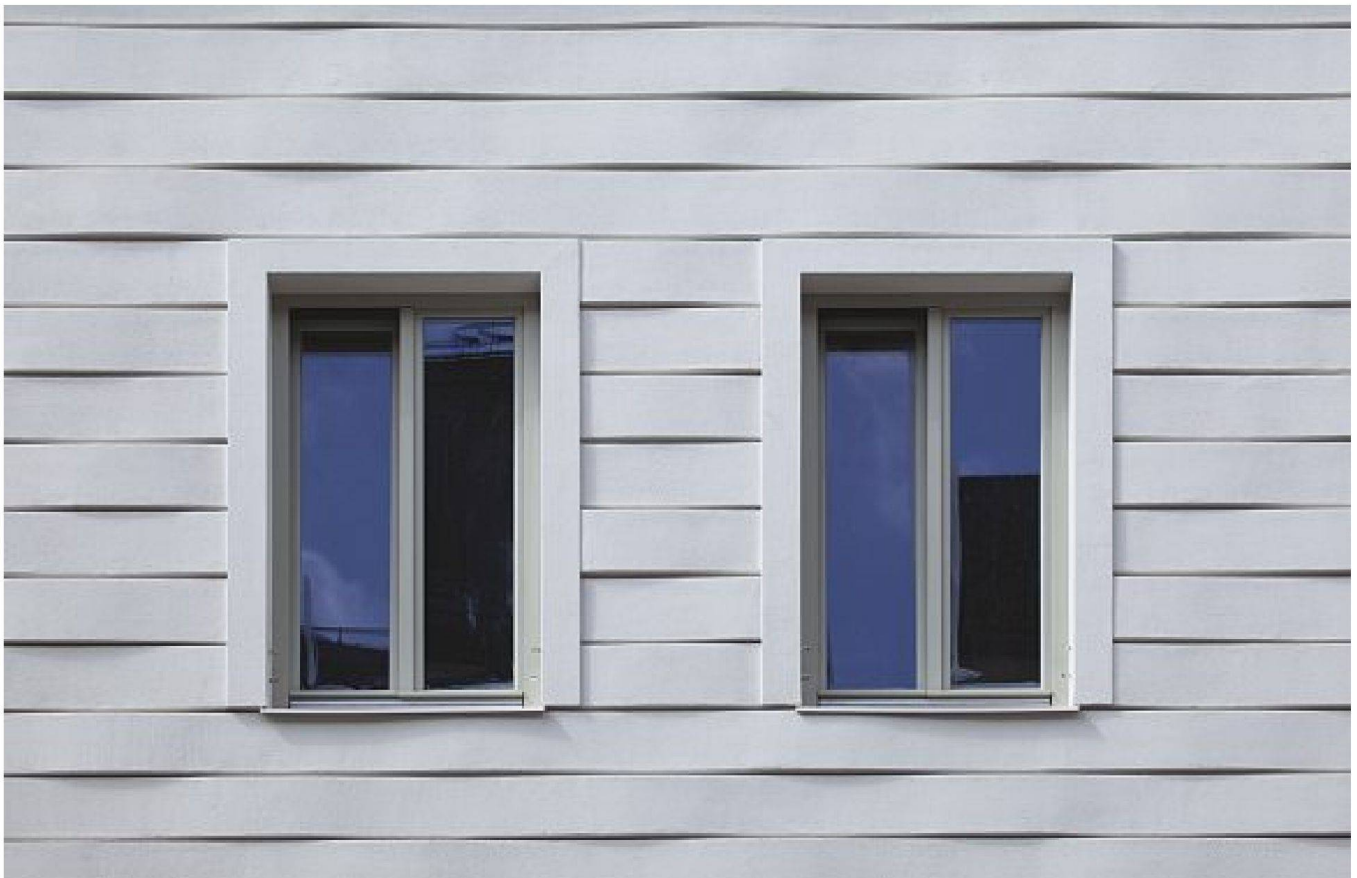
Wohnhaus Reichenbachstrasse 20 in München. Das verfremdete Bossen-Motiv erzeugt ein wellenförmiges Relief.
