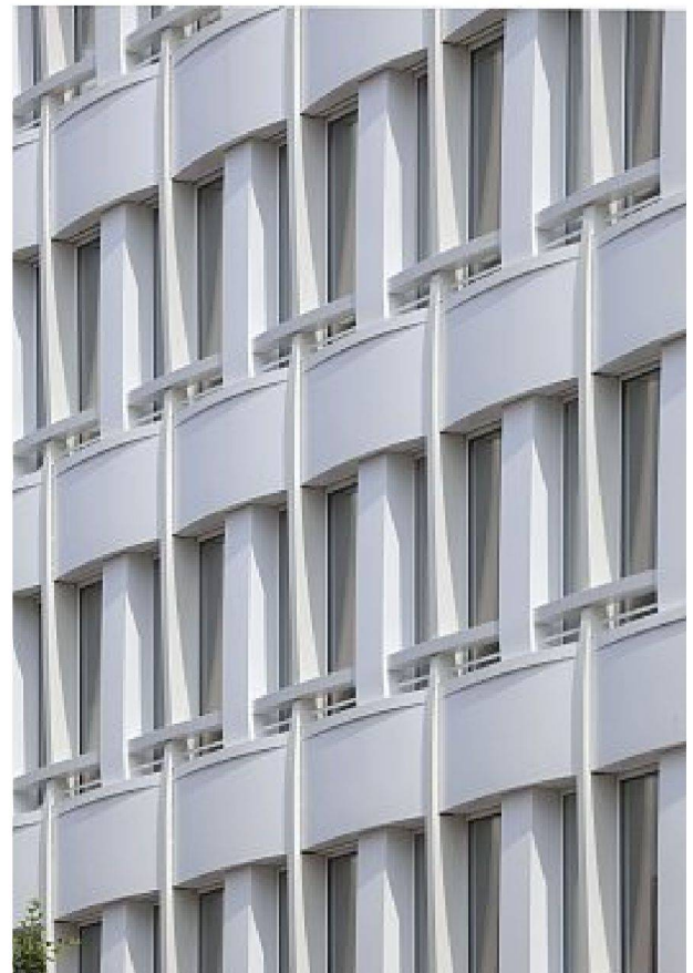
Agfa-Hochhaus, Metallfassade aus pulverbeschichtetem Aluminiumblech
