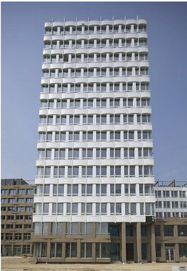
Agfa-Hochhaus, Sockelfassade aus ineinandergefügten Betonfertigteilen, darüber Metallfassade
