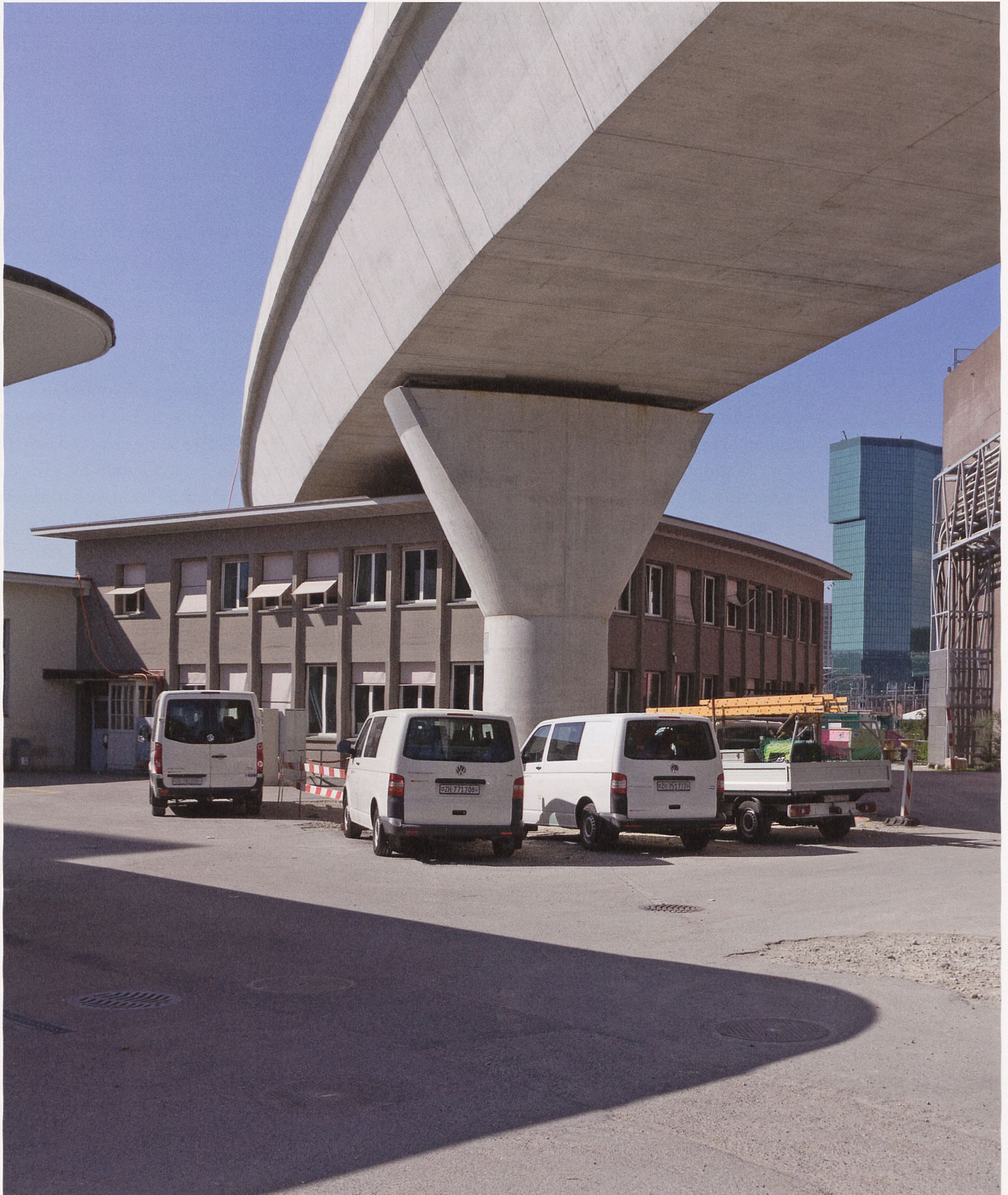
Neuer Massstab im Gleisfeld vor dem Zürcher Hauptbahnhof: Die Kohlendreieckbrücke verläuft haarscharf über ein denkmalgeschütztes Dienstgebäude von Hans Hilfiker, rechts im Hintergrund der Prime Tower. Bild: Caspar Schärer
