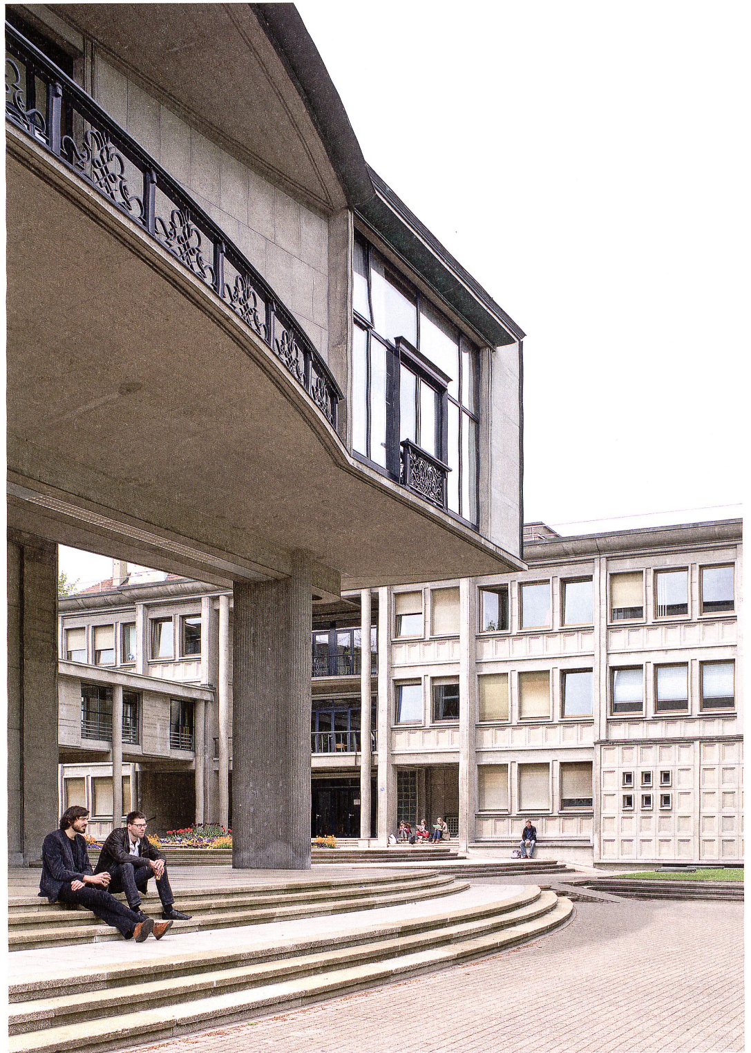
Universitätsgebäude Miséricorde der Architekten Denis Honegger und Alexandre Dumas, 1937–41. Der vornehme, grosszügige Zentralkorpus auf mächtigen Pfeilern ist in Stahlbeton ausgeführt und mit Stahlgittern des Atelier Brandt geschmückt. Er beinhaltet vornehmlich das Rektorat und, im hinteren Teil, die grosse Aula der Universität. Im Hintergrund ruht der Seminartrakt mit seinen charakteristischen Hebefenstern.
