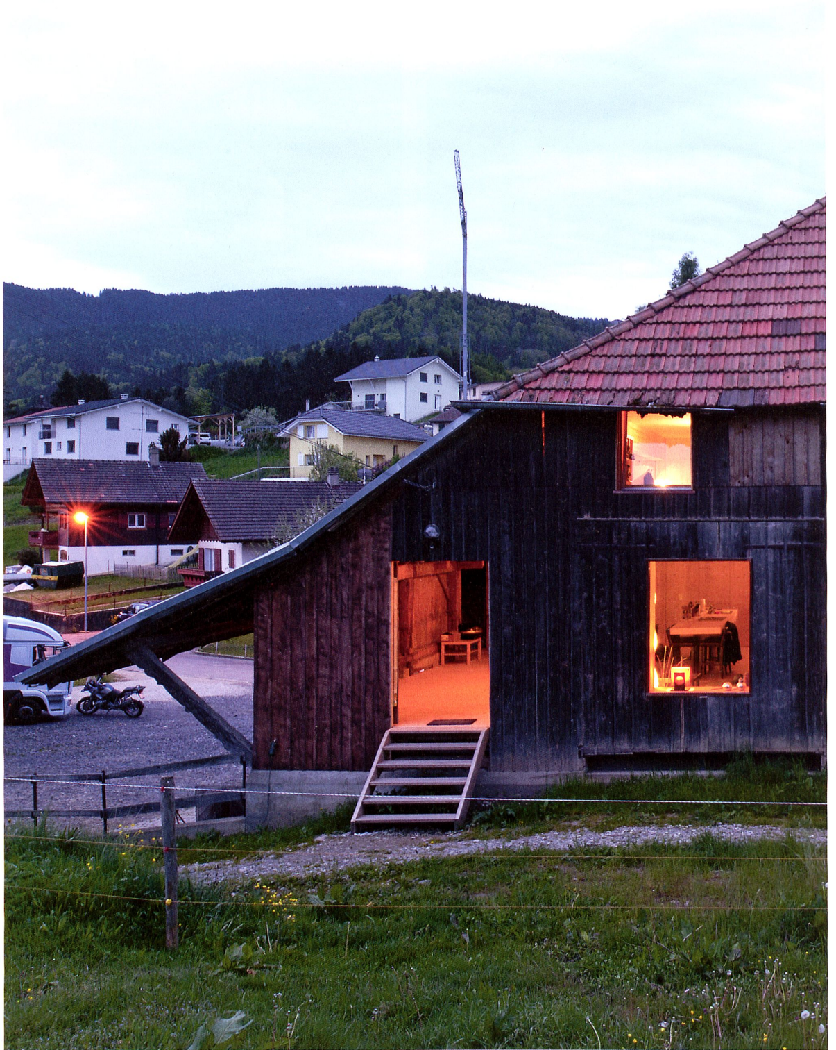
Umbau von Bauernhaus und Scheune durch LVPH architectes. Bild: Jérôme Humbert
