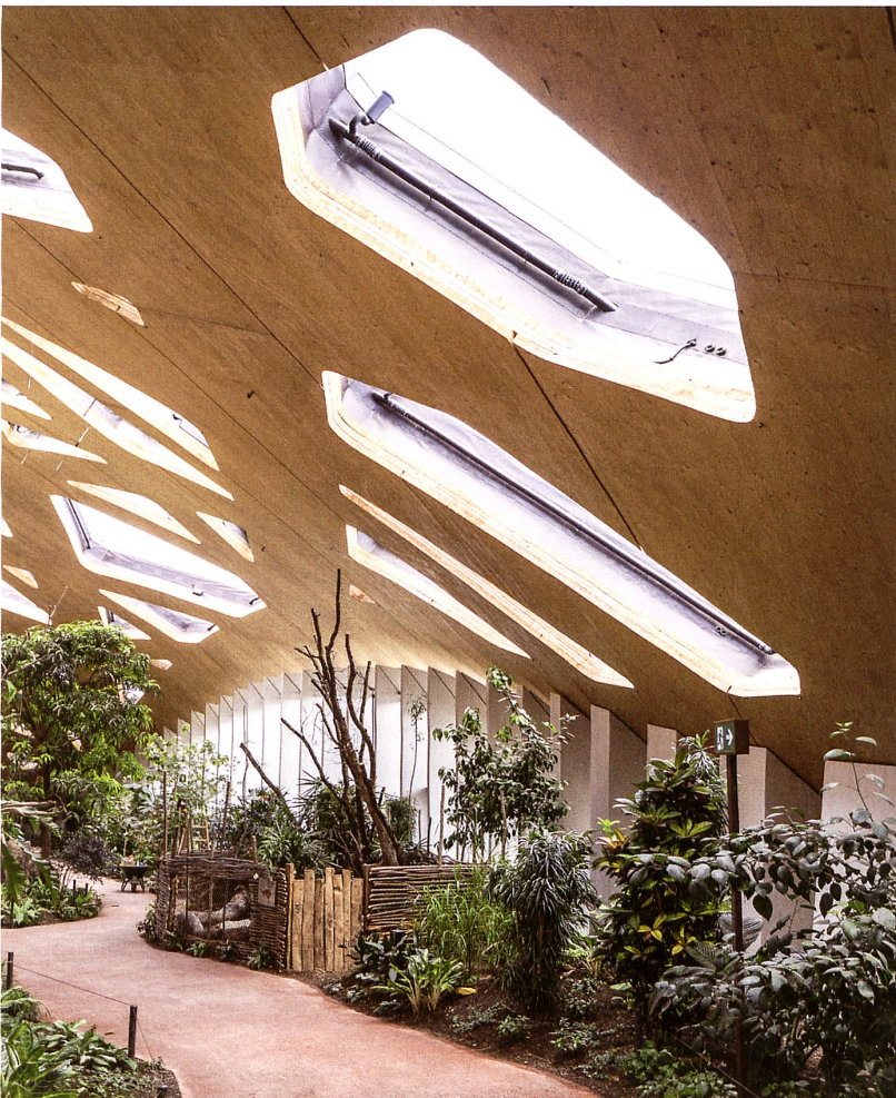
Aufgeworfener Rand und verschobener Hochpunkt machen aus dem Dach eine komplexe, lebendig wirkende Form. Die Schale aus naturbelassenem Holz bildet das Haupttragwerk; grau gestrichenen sind sekundäre Tragelemente und Installationen.
