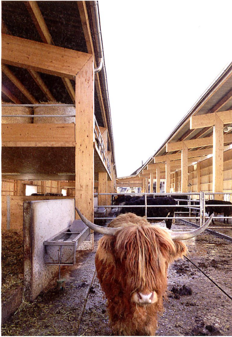
Der Laufstall des kantonalen Hofs Wildenstein wurde von Kury Stähelin Architekten als Musterbau in empfindlicher Landschaft entworfen. Der Laufhof liegt hier in der Mitte der Anlage. Bild: Thomas Jantscher
