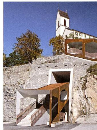
einzelne Elemente wurden auf dem unwegsamen Gelände mit ausgeklügelten Arbeitsvorgängen bergwärts montiert. Das Zusammenschweißen der einzelnen Elemente erfolgte vor Ort durch den Stahlbauunternehmer. Zum Auftrag von Tuchschmid gehörte auch die Herstellung, Lieferung und Montage des gewellten, rostfarbenen Treppengeländers aus Lochblechen.
