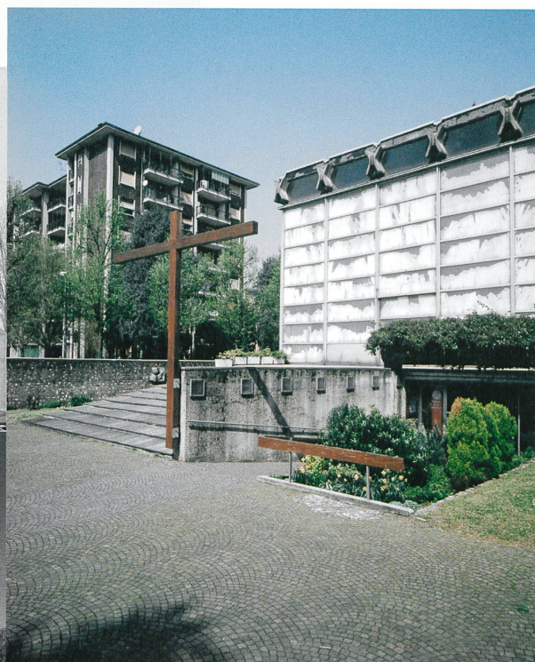
Facciata sud, una croce lignea separa i due accessi alla chiesa. Foto: Martin Feiersinger
