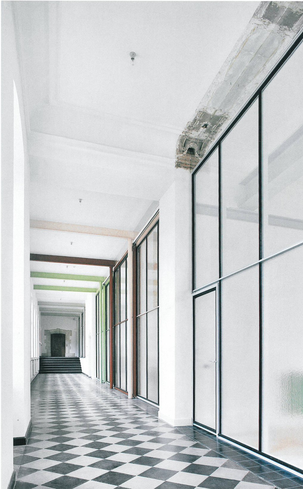
Kantoren famous: Eine Glaswand ersetzt die tragende Wand; die Farbe der Fensterprofile verweist auf die vorgefundenen Farben der Räume dahinter.
