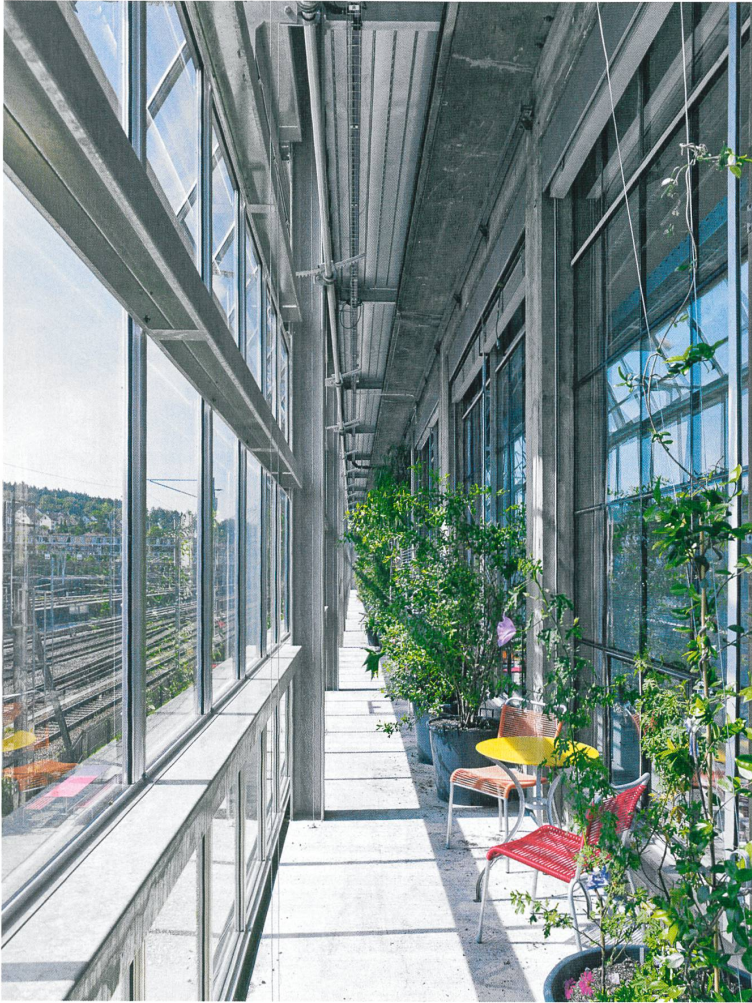
Die Wintergartenschicht zum Gleisfeld hin verschafft bestehenden und ergänzten Teilen eine neue Haut und ein exotisches Klima (oben). Rauminszenierung in der mehrgeschossigen Eingangshalle (unten).
