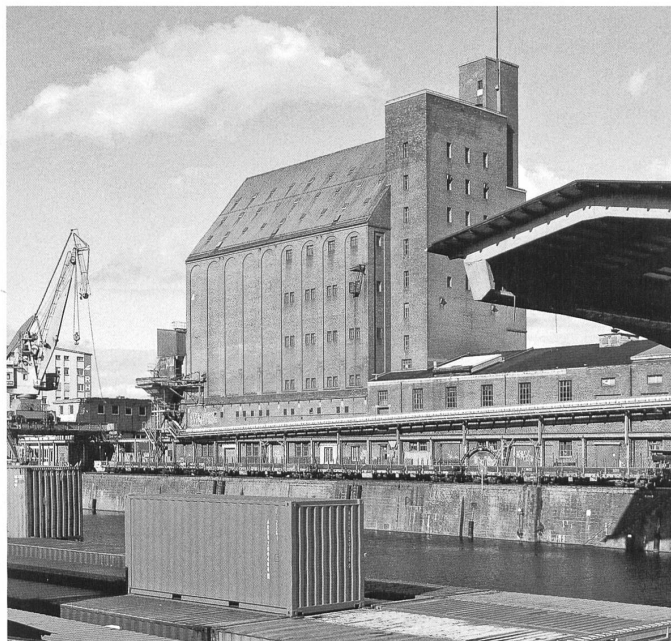
Das «Bernoulli-Silo» im Basler Hafen, 1923–26 von Oskar Bosshardt und Hans Bernoulli erbaut, zeugt von der Faszination für die «anonyme» Architektur grossmasstäblicher Zweckbauten, wie sie seit dem berühmten Jahrbuch des Deutschen Werkbunds von 1913 unter Architekten verbreitet war. Bild: Klaus Spechtenhauser, Kantonale Denkmalpflege Basel-Stadt
