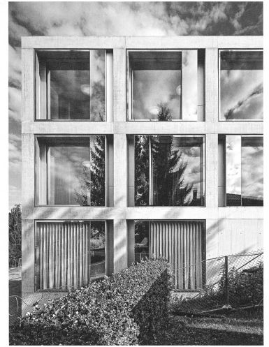
Au sud et à l'ouest, la façade se décline dans une double peau remplissant la grille de la structure en béton. Derrière les surfaces miroitantes se rangent les rideaux de protection solaire. Photo: Roger Frei
