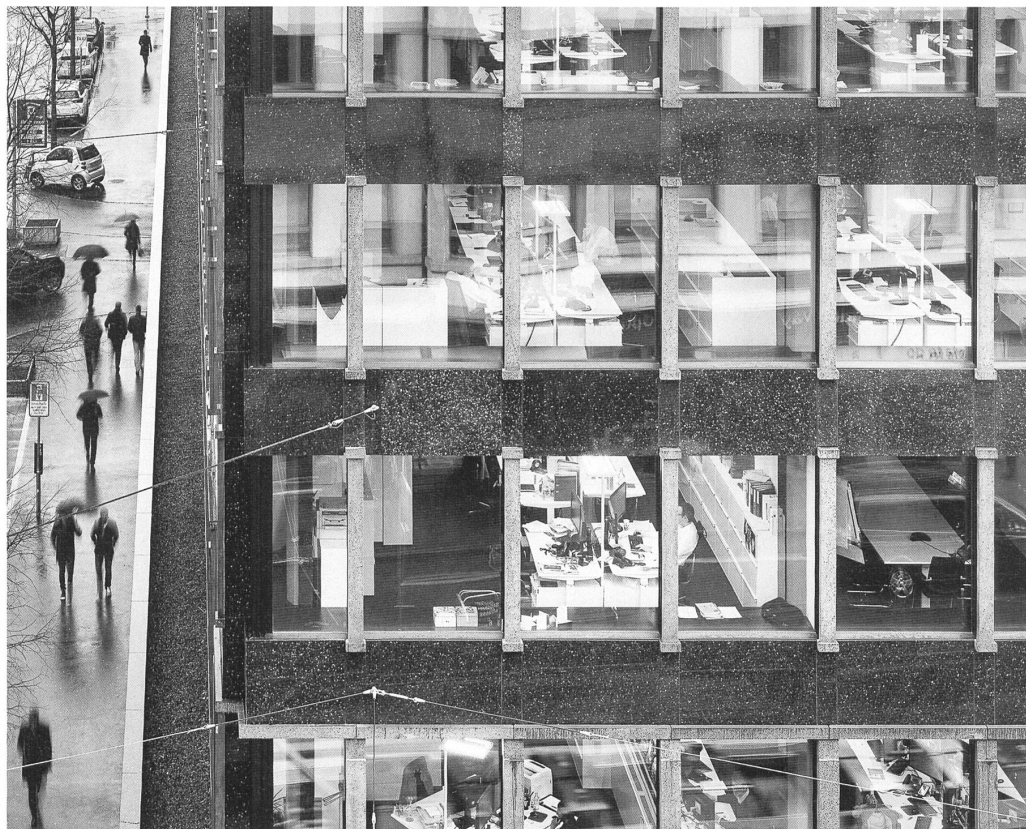
Umbau eines Geschäftshauses am Bleicherweg in Zürich, Peter Märkli 2014 Bild: Walter Mair
