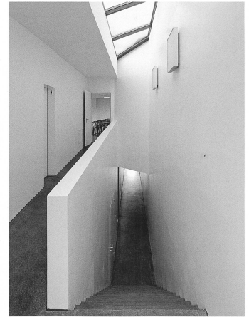
Durch das versteckte Oblicht gelangt Tageslicht bis zu den Garderoben im Untergeschoss.
