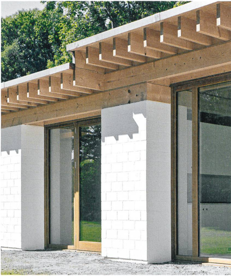
Raumhaltige, gemauerte Schotten tragen die Holzelemente des Dachs. Bilder: Roland Bernath
