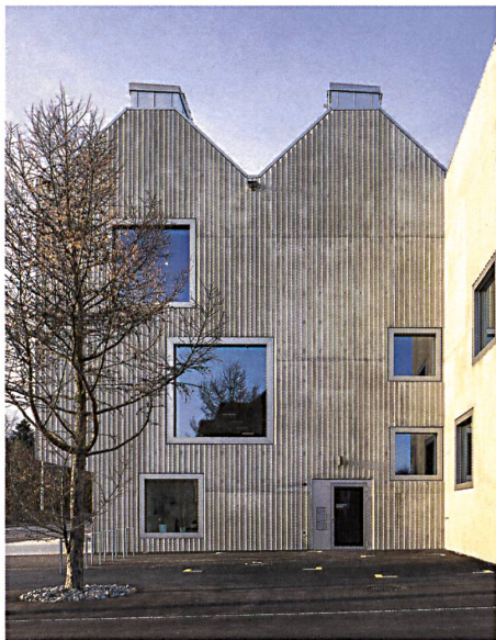
Der komplexe Baukörper des Naturmuseums von Meier, Hug und Semadeni schafft im St. Galler Osten einen neue Heimstatt. → S. 70 Bild: Roman Keller
