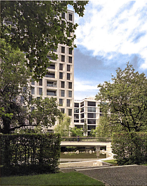
Der nördliche Bauabschnitt ist seit 2016 fertig. Die grüne Umgebung am freigelegten Bachlauf und der eindrucksvolle Baumbestand an der Berliner Strasse zur Ostseite prägen das Bild.
