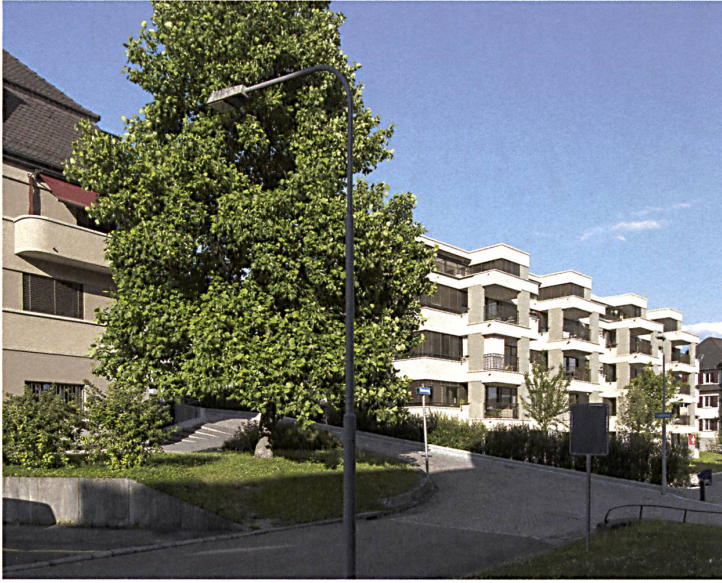
Der grüne Binnenbereich mit Blick auf die Ersatzneubauten von Harder Spreyermann Architekten (2016). Bild: Walter Mair
