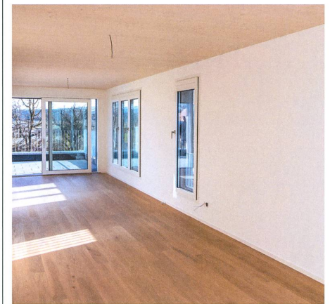
Attikawohnung in Grossaffoltern mit TS3-Geschossdecken
