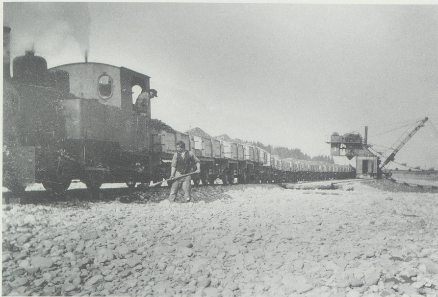
Rheindamm-Erhöhung oberhalb Haag im Winter 1928/29. (Bild: Staatsarchiv St.Gallen.)
