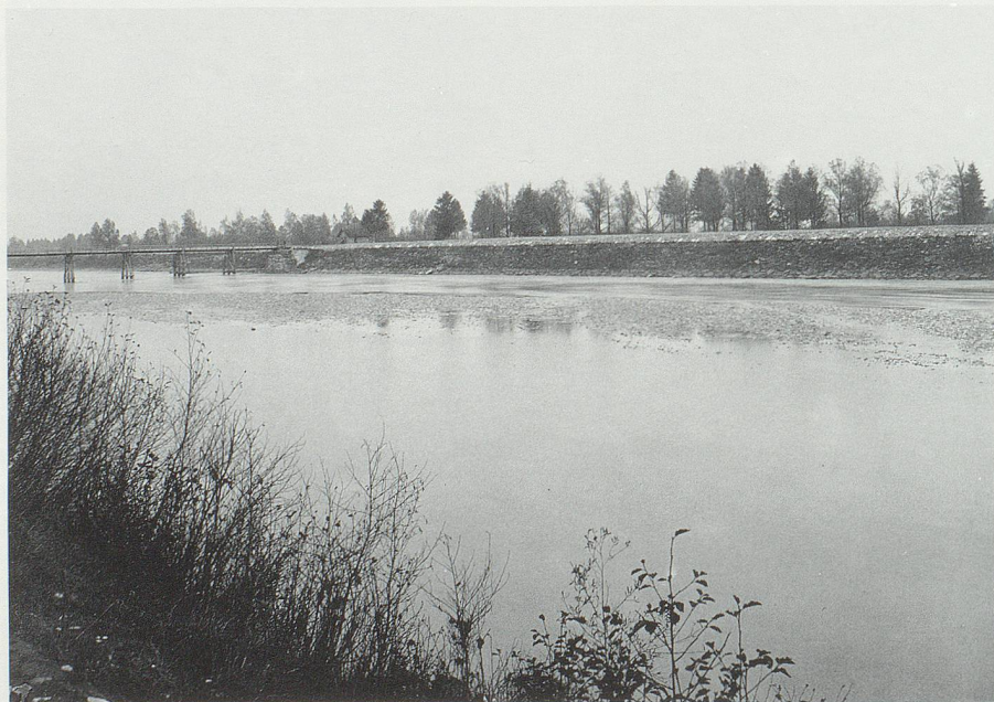
Rhein bei Buchs im November 1928: 200 Meter oberhalb der provisorischen Strassenbrücke Buchs-Schaan; gut erkennbar das nach der Überschwemmungskatastrophe von 1927 erhöhte Wuhr auf der Liechtensteiner Seite. (Bild: Staatsarchiv St.Gallen.)
