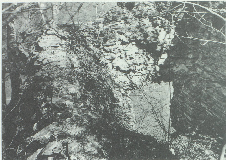
Innenansicht des talseitigen Raums von Frischenberg mit Blick gegen Osten 1941. (Bild H. Rudolph Inhelder, Frümsen.)
