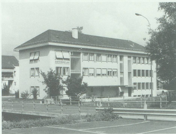
Verwaltungsgebäude der im Jahr 1901 gegründeten internationalen Spedition an der Technikumstrasse, Buchs
