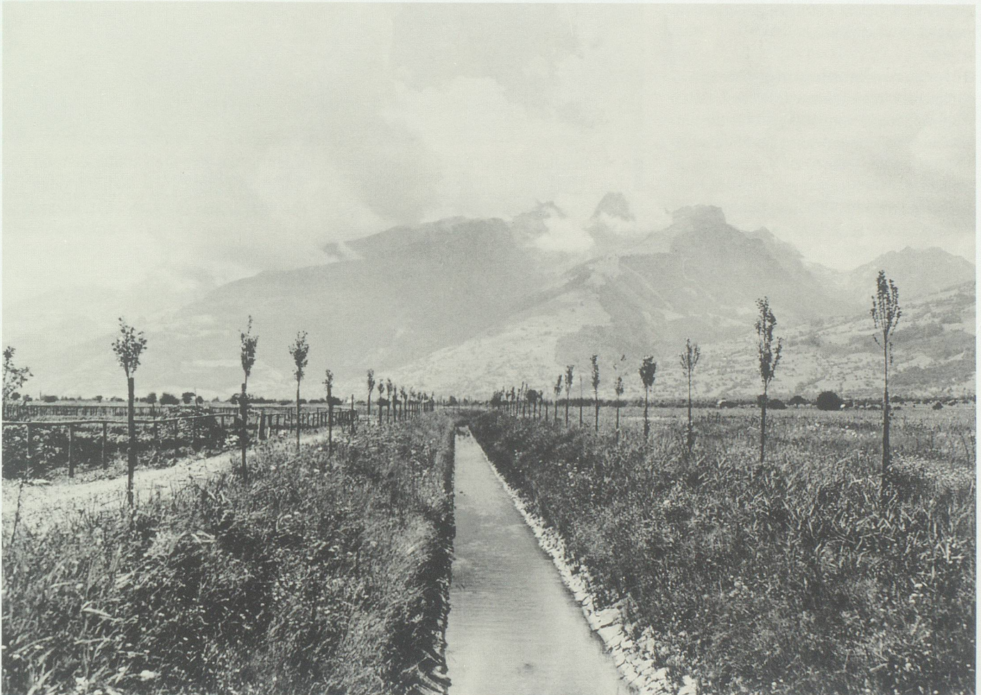
Abb. 39. Ein von Sax nach Salez führender Entsempfungskanal und die kanalisierten zahlreichen Bachläufe bilden den um 1920 gelegten Grundraster für das heutige Aussehen des Saxerriets. Blick «von der Brücke bei der Kolonie gegen Süden» am 14. Juli 1927. Bild im Staatsarchiv St.Gallen.
