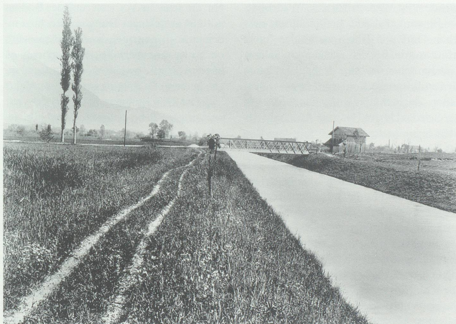
Abb. 18. Der Werdenberger Binnenkanal, gebaut 1882–1886, (Aufnahme um 1895 bei Haag) ermöglichte als Vorfluter die Korrektur der Seitenbäche und die grossflächigen Entwässerungen in der Talebene. Er war damit auch wesentliche Voraussetzung für die Werdenbergische Güterzusammenlegung bei Haag. Bild im Staatsarchiv St.Gallen.
