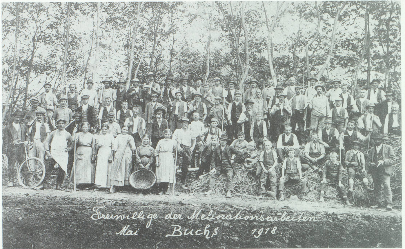
Abb. 5b. «Freiwillige der Meliorationsarbeiten» im Mai 1918 bei Buchs. Damals wurde ein erster grösserer Teil des heutigen Landwirtschaftsbetriebes «Ceres» gerodet und urbarisiert. Bild bei Ernst Engler, Grabs.
