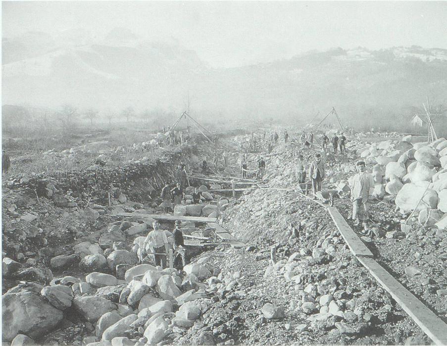
Abb. 24. Die Korrektur der Simmi war Voraussetzung für die Güterzusammenlegung im Gamser Simmigebiet von 1900–1905. Wie beim Grabserbach mussten mit grossem Aufwand die alten Dämme abgetragen und das Gelände planiert werden. Bild bei Noldi Kessler, Gams.
