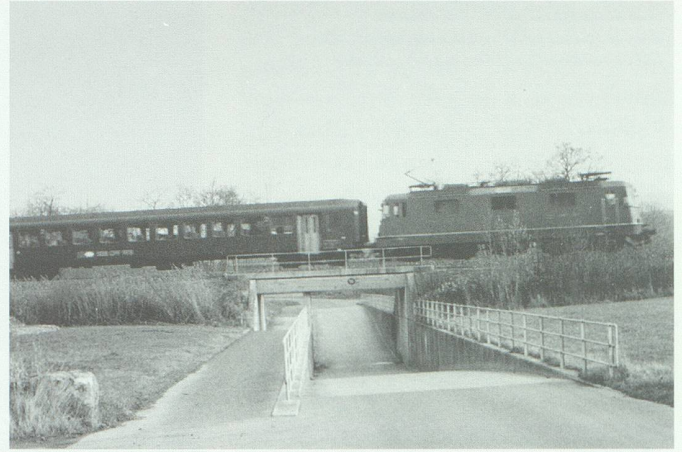
1984/85 wurde durch SBB, Bund, Kanton, Gemeinde und Melioration im Rohert diese Bahnunterführung gebaut. Der schlechte Baugrund stellte grosse technische Anforderungen. Zudem musste wegen des Bahnverkehrs viel Nachtarbeit geleistet werden. Bild: Ernst Wiget, Altstätten.
