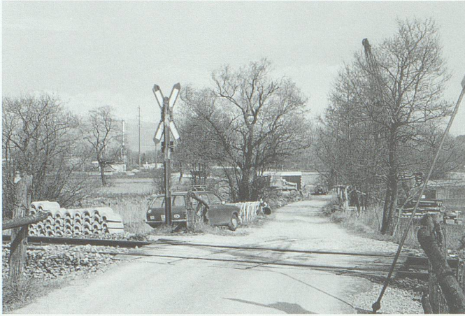
Im Zuge der Güterzusammenlegung wurde es möglich, sieben ausserordentlich gefährliche, unbewachte Bahnübergänge zu eliminieren. Blick auf den früheren Übergang im Rohert bei Sennwald. Bild: Graf & Tinner, Haag.
