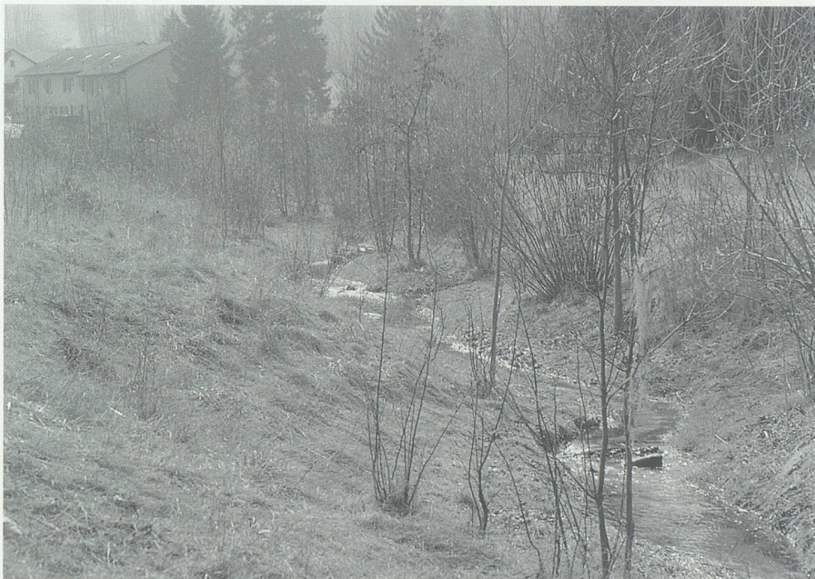
Sagentobelbach bei Dübendorf, neu angelegt im Zuge einer Verlegung infolge des S-Bahn-Baus. Bild: Christian Göldi, Schaffhausen/Zürich.
