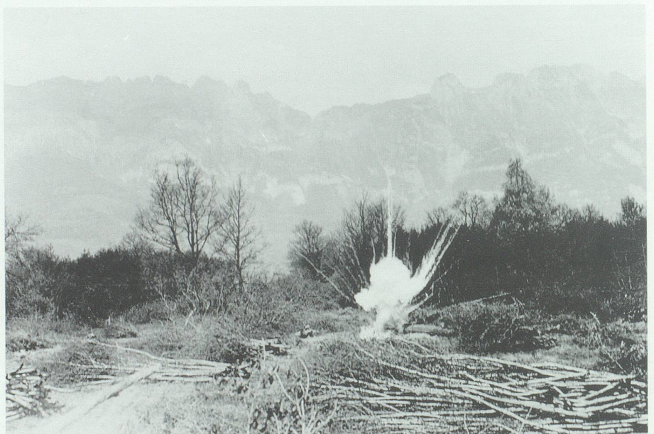
Grosse Wurzelstöcke mussten mit Schwarzpulver gesprengt werden. Rodung 1918 bei Buchs. Bild Staatsarchiv St.Gallen.
