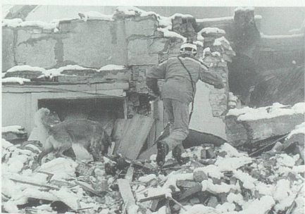
31. März: Das in Abbruch befindliche alte Salezer Primarschulhaus wird für eine Katastrophenübung genutzt.
