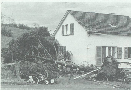
26. Januar: Der Sturm «Wilma» richtet beträchtliche Schäden an. Beschädigtes Haus an der Zubengasse in Sennwald.
