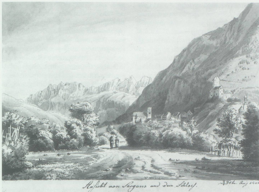
Abb. 11. Diese Zeichnung Heinrich Schilbachs der alten Landstrasse bei Sargans vermittelt einen Eindruck von den Strassenverhältnissen vor dem Bau der Kantonsstrassen. Aus Schilbach 1818.
