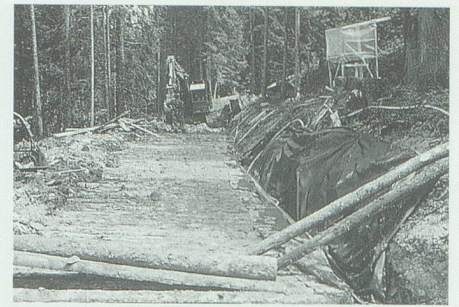
Bau der Hertistrasse in Grabs 1990 mit Prügelrost und Sickerleitung.
