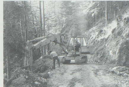
Beim Bau der Hübschenwaldstrasse 1988 in Sax.
