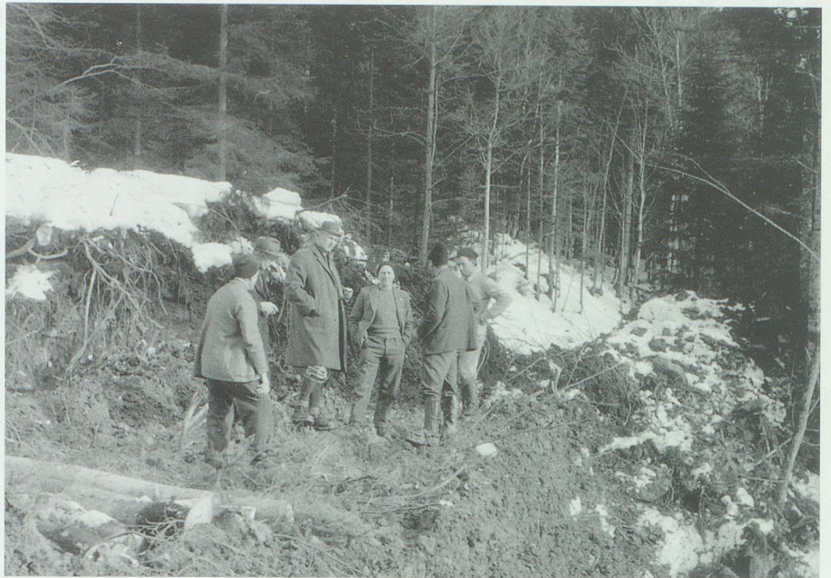
Waldstrassenbau Oberschwendi–Fadura in Gams (1964/65). Baudiskussion im Hundskennel.
