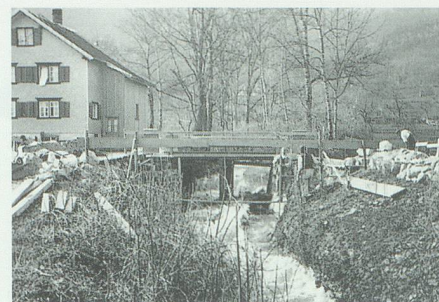
Bau der Steinenbach-Brücke in Sennwald (1935).
