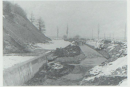
Korrektion von Strasse und Mühlbach beim Seidenbaum im Jahr 1935.
