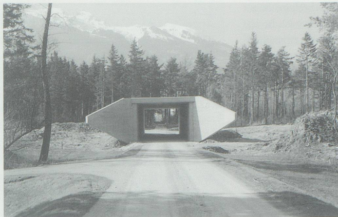
Obwohl die N 13 optimale topographische Voraussetzungen hat, waren dennoch Kunstbauten für Unter- und Überführungen notwendig. Im Jahre 1977 stand diese Unterführung noch als «Fremdkörper» im Alberwald bei Weite. Bild: Abteilung Brückenbau.
