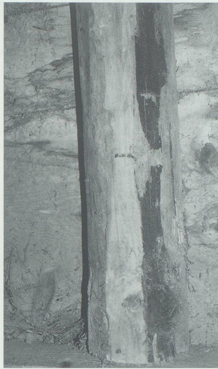
Deckenbalken im Tenn des Hauses Litscher, Sevelen: Teil eines Freiheitsbaums in den Farben Schwarz-Rot-Grünblau. Bilder: Gerhard R. Hochuli, Buchs.
