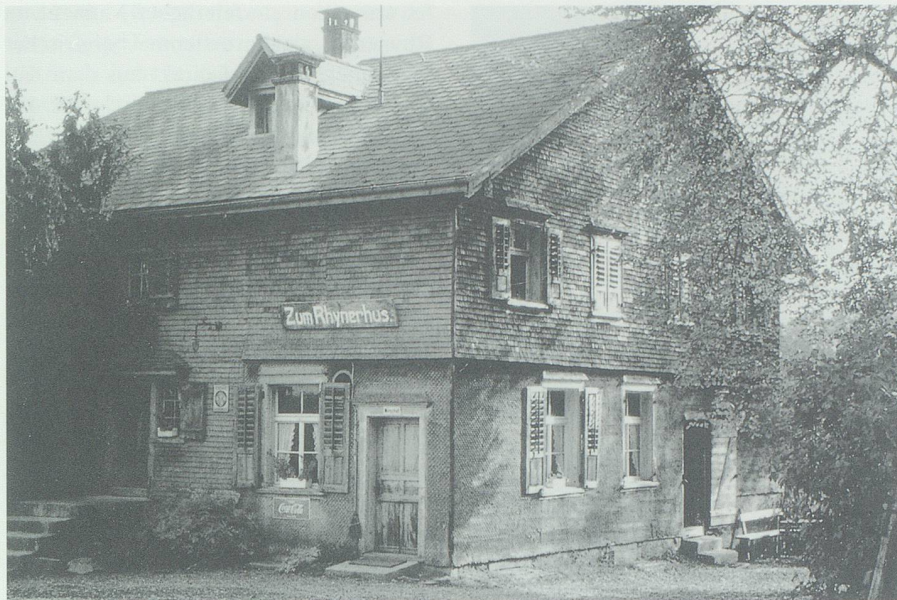
Das Rhynerhus vor der letzten Renovation.
