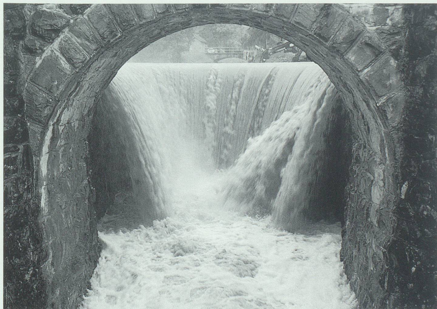
Hochwasser vom 15. Februar 1990: Auslauf des Kiesfangs im Grabserbach. Bild: Andreas Gasenzer, Grabs.
