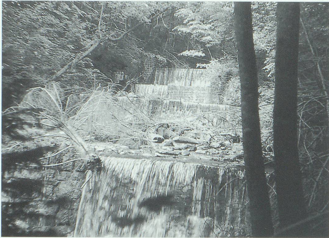
Oft bleibt Schwemmh Holz an der Kante einer Mauer liegen. Bild: Eugen Henauer, Buchs.
