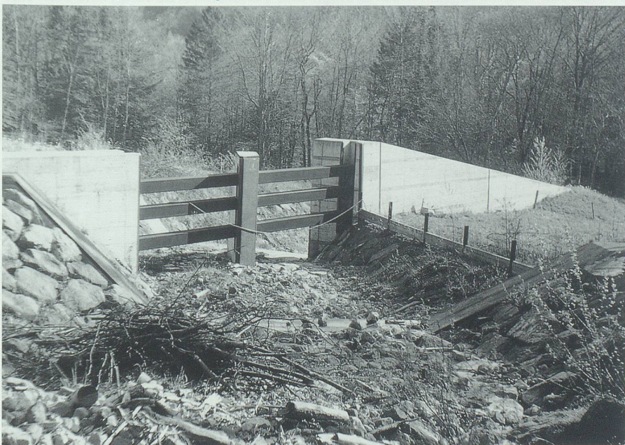
Murgangabweiser im Sevelerbach bei Matinis: Rechts vom Rechen ist der Notüberfall sichtbar, der das Geschiebe auf eine bewirtschaftete, aber unbewohnte Liegenschaft leitet. Bild: Eugen Henauer, Buchs.
