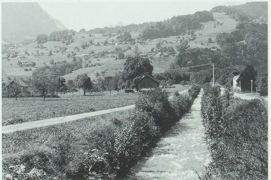
Bis in die 1980er Jahre entsprach eine gerade, gesicherte Linienführung eines Baches der Vorstellung einer wirksamen und sicheren Verbauung, wie hier die Simmi zwischen Hasengut und Wolfhag. Bild: Eugen Henauer, Buchs.
