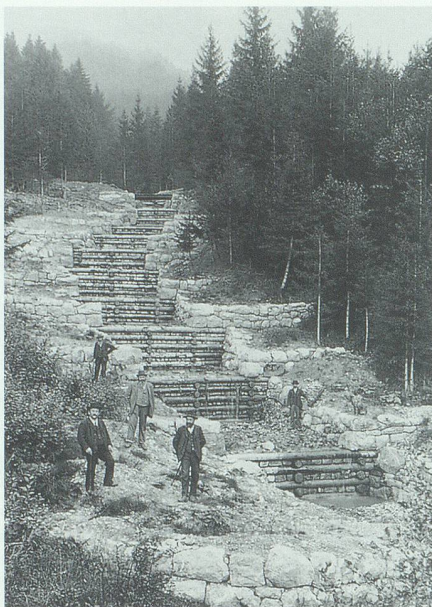
Fertigstellung der Hauptsperren im Gasenzenbach um 1905. Bild im Staatsarchiv St.Gallen.
