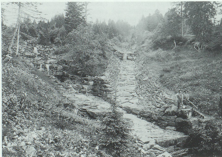
Einmündungsbauwerk des Vordertrüebbachs in den Hintertrüebbach im Jahr 1899. Bild im Staatsarchiv St.Gallen.
