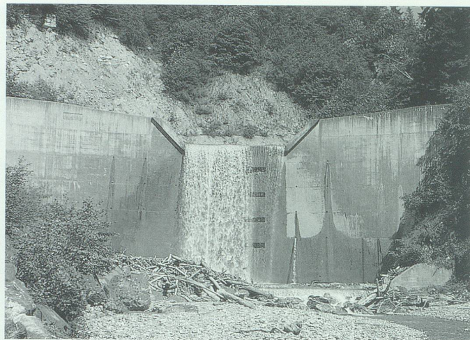
Für ganz grosse und hohe Mauern muss die Lösung mit Stahlbeton gesucht werden. Schraubachtobel bei Schiers GR. Bild: Eugen Henauer, Buchs.
