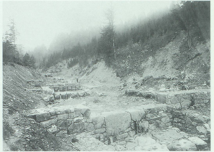
Massive Blockmauern stabilisierten das Bachbett der Simmi, konnten aber den Materialtransport von oben nicht aufhalten. Bild von 1891/92 im Staatsarchiv St.Gallen.
