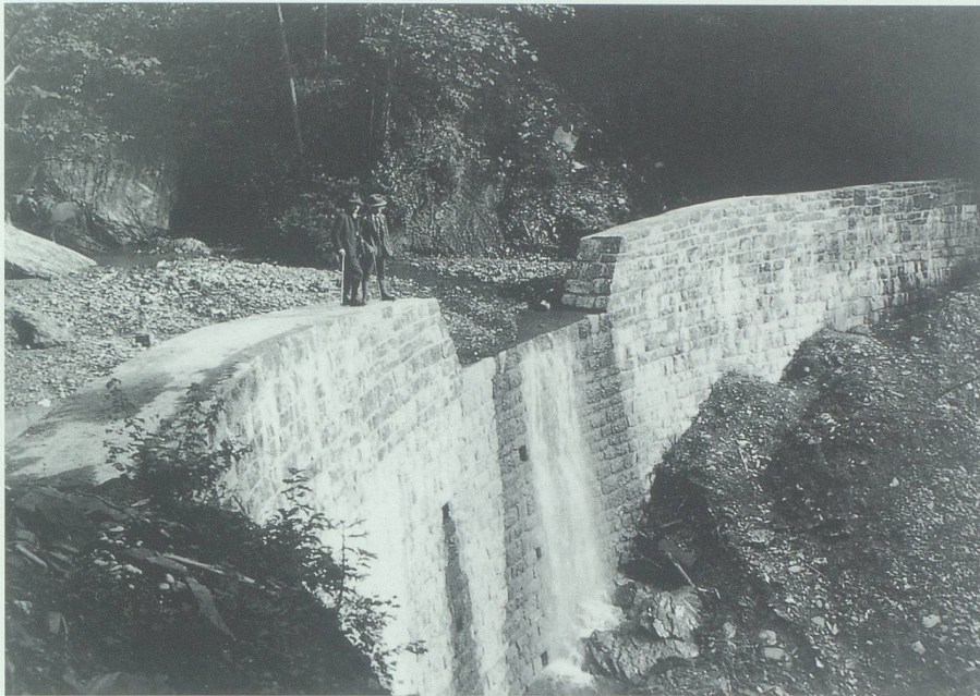
Mit Natursteinen verkleidete Betonmauer im Trüebbach, 1935, etwa drei Jahre nach Erstellung. Bild im Baudepartement des Kantons St.Gallen, Sektion Wasserbau.
