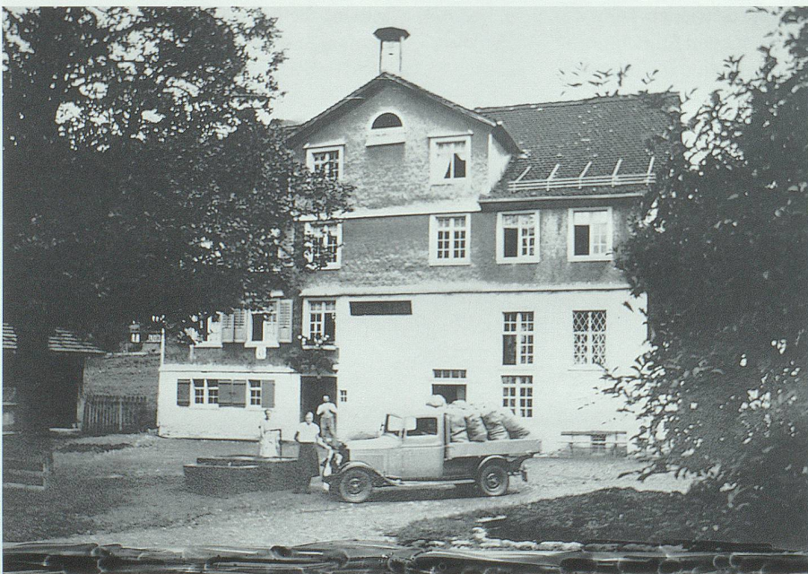
Die Mühle zur Glocke auf einer um 1930 aufgenommenen Fotografie.
