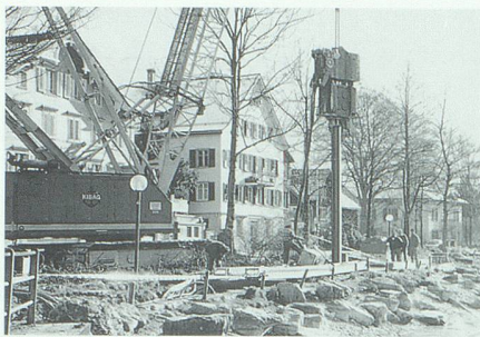
3. Februar: Mit einer Spundwand soll der Werdenbergersee gegen Wasserverlust gesichert werden.
