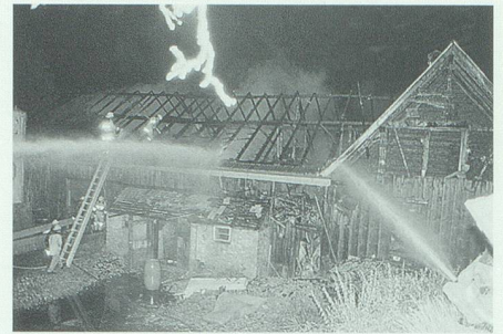
12. August: Trotz schnellem Einsatz kann die Gamser Feuerwehr das Müllerhaus am Gamserberg nicht mehr retten.
