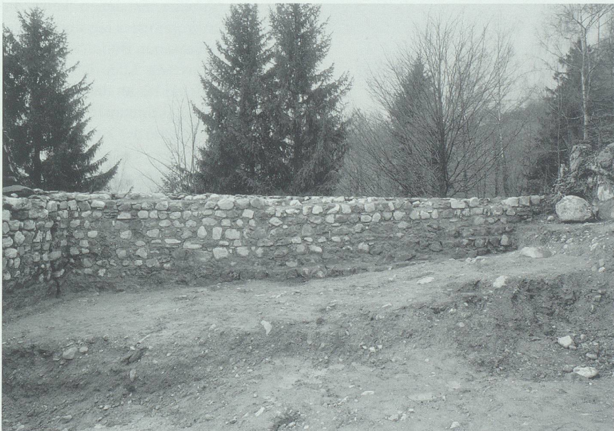
Abb. 7. Innenschale der Südmauer. Im Gegensatz zu den trutzigen Aussenschalen (vgl. Abb. 2) bestehen die Innenschalen aus kleinteiligem Steinmaterial.
