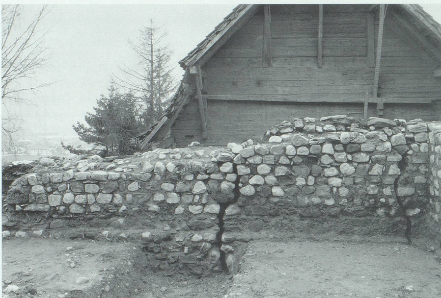
Abb. 8. Auswirkungen eines Erdbeutes, möglicherweise durch ein Erdbeben ausgelöst: Die im Bereich der Türschwelle auseinander gerutschte und abgesackte Ostmauer (oben, Bildmitte). 7 bis 30 Zentimeter breite Vertikalisrisse durchziehen die gesamte Dicke der Ostmauer (unten).
