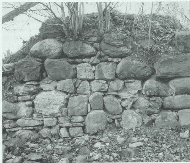
Abb. 2. Aussenschale der Nordmauer und Nordwestecke des Wohnturmes (Aufnahme 1999). Die Eckquaderung enthält bis 70 mal 50 Zentimeter grosse Steinblöcke.
