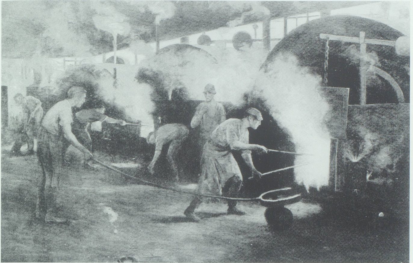
Abb. 16. Der Puddler zieht einen Klumpen Schweisseisen aus dem Puddlingofen. Sein Gehilfe wird das glühende Metall mit dem Transportwagen zum Auswalzen bringen. Bild im Welsh Industrial and Maritime Museum.
