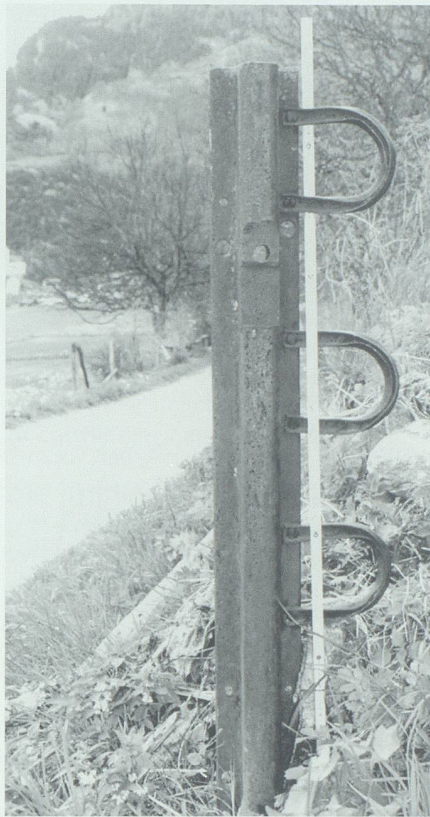
Abb. 1. Brückenschiene als Zaunpfosten bei Tomils im Domleschg.
