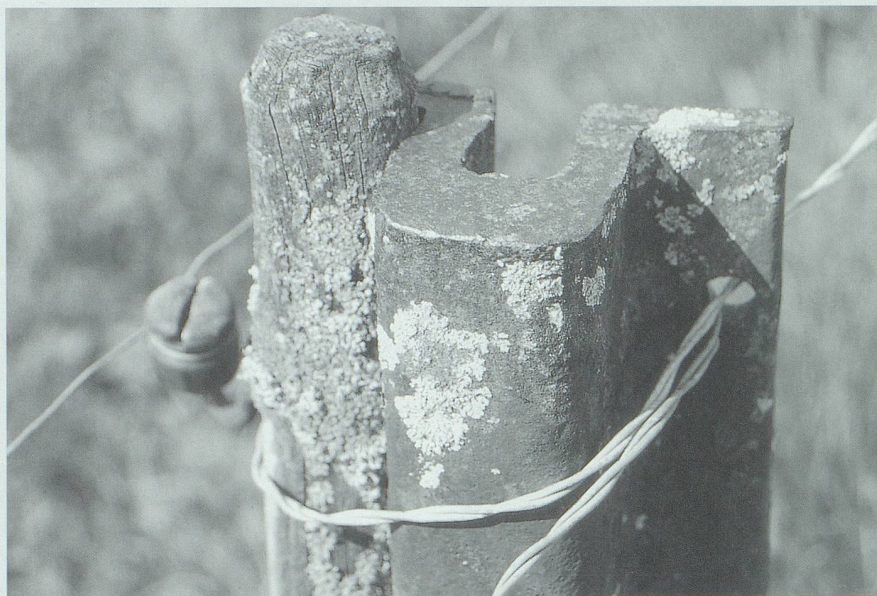
Umfunkionierte Eisenbahnschiene aus der Mitte des 19. Jahrhunderts: Einer der beiden als Brückenschienenstücke identifizierten Zaunpfosten im Rossmad bei Haag. Bild 2001: Hans Jakob Reich, Salez.
