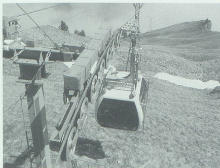
12. Mai: Die erneuerte Seilbahn Frümsern-Stauberen nimmt ihren Betrieb auf.
