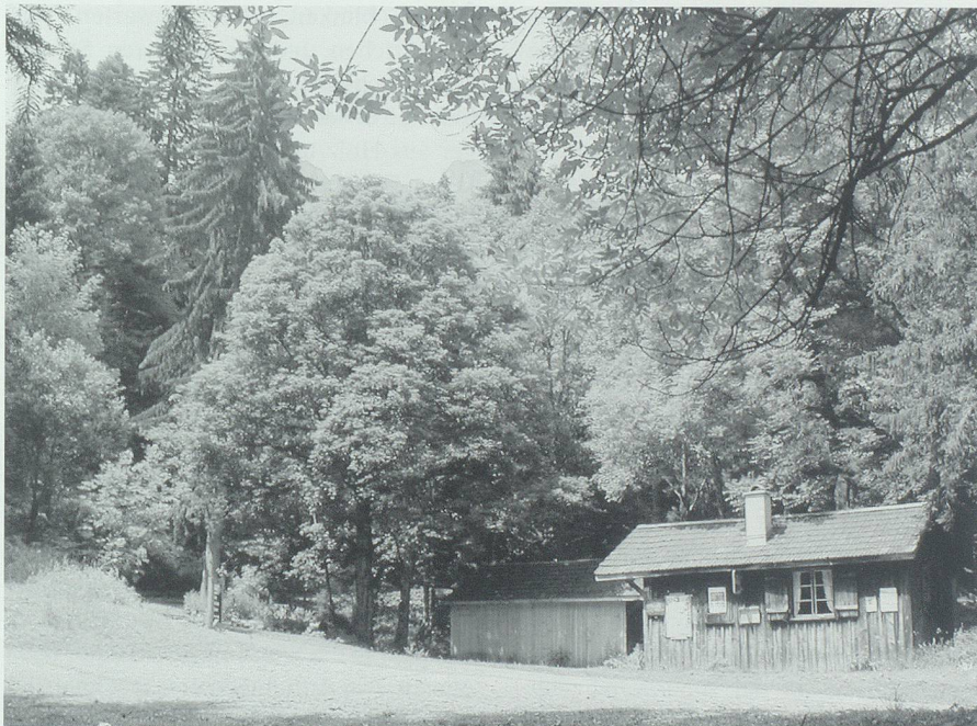
Beim Schnapsrotzen, Wartau: Die beiden ehemaligen Militärbaracken dienen den Fuhrleuten und Pferden als Unterkunft beim Holzschleipfen.
