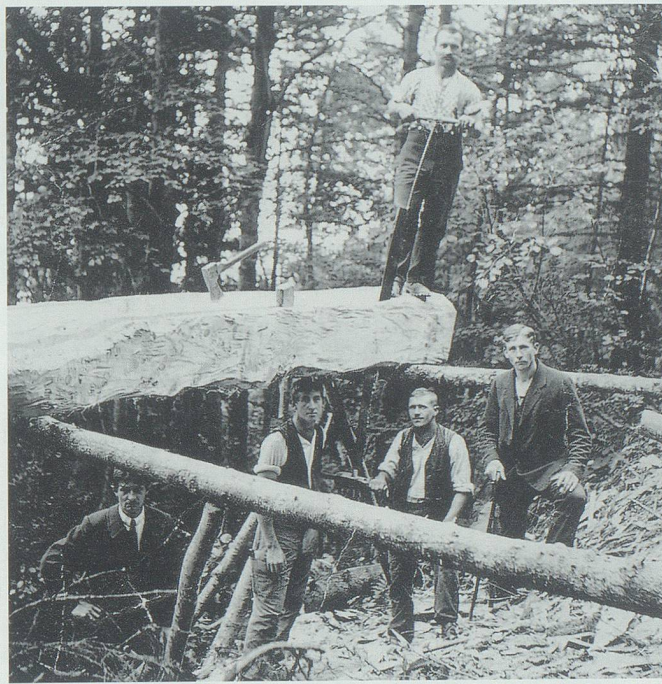
Noch in den ersten Jahrzehnten des 20. Jahrhunderts wurden Balken für den Bau von Alpgebäuden im nahe gelegenen Bergwald in anstrengender Handarbeit zugelegt, wie dies das Bild aus den 1920er Jahren dokumentiert. Es entstand anlässlich des Baus des Rieter Scherms im Rieterwald/Cholplatz (Gemeinde Wartau). Oben an der Säge Hans Heeb, Zimmermann, unten an der Säge rechts Jöri Schlegel und links Emil Caprez; ganz rechts (mit Stock) Baumeister Hans Schmidt. Bild in Privatbesitz.
