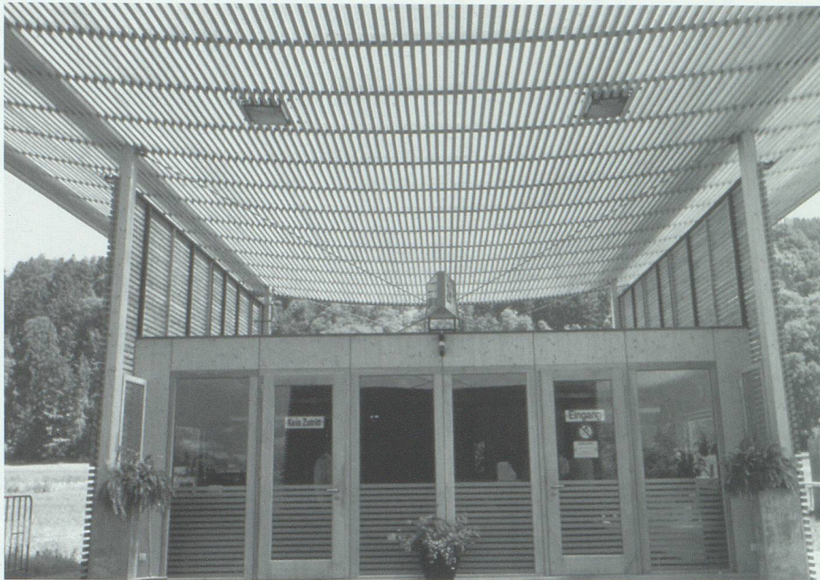
Abb. 2. Der Grenzübergang Ruggell-Nofels (Effeft Architekten AG, Triesen). Bild: Holzkreislauf Liechtenstein.
