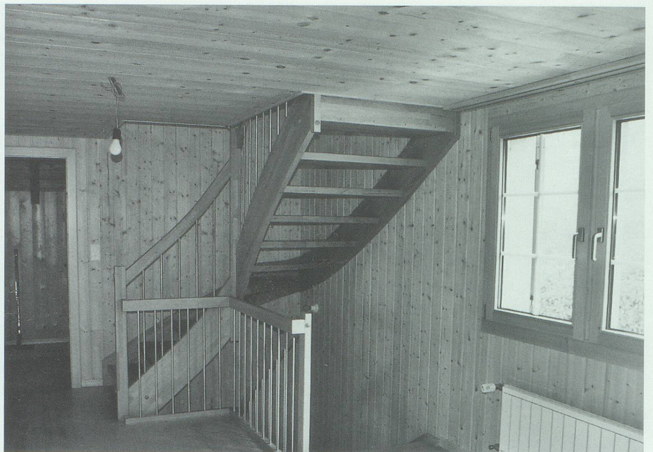
Diese Treppe (Bild links) ist etwas steil, und die Treppenkanten sind massiv ausgelassen. Die neue Treppenkonstruktion (rechts) weist ein ideales Treppenverhältnis auf.
