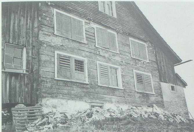
Das alte Schindelkleid wird demontiert. Darunter kommt eine gut erhaltene Strickwand zum Vorschein. Sie gehört zum ursprünglichen Bestand des Gebäudes, während der Anbau links später hinzukam.
